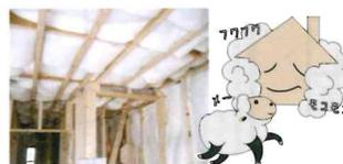
**eco羊毛の断熱材サモウル厚み105mm**
