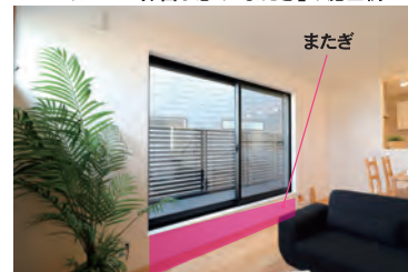
バルコニー掃出し窓の『またぎ』の施工例
